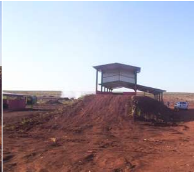
Foto 76 - UPL de Nova Alvorada do Sul. Fonte: Relatório de inspeção 278/2006 - Vigilância Sanitária/MS.
