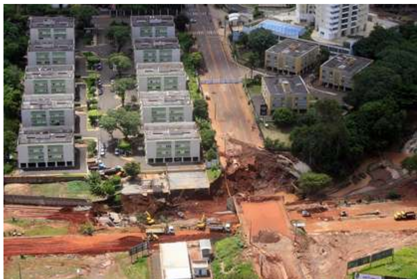
Foto 82 – Danos causados pelas chuvas em Campo Grande, em fevereiro de 2010.
