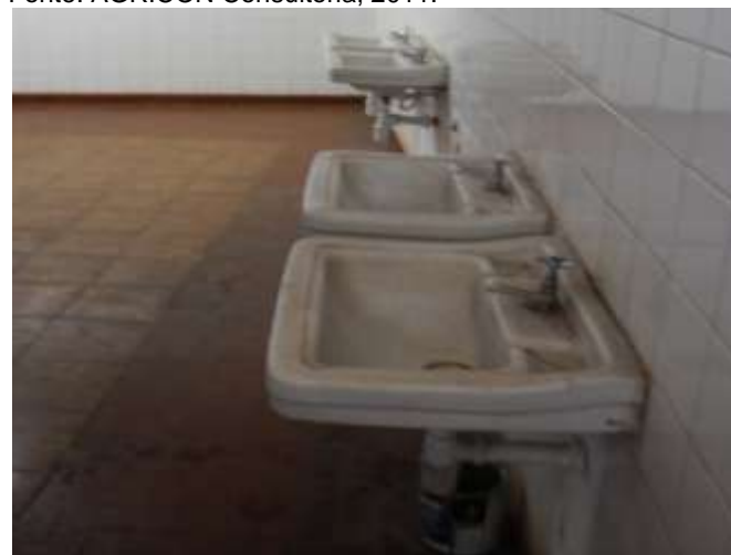
Foto 48 – Banheiro do Morenã. Fonte: AGRICON Consultoria, 2011.
