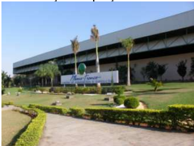
Foto 29 – Vista externa do Centro de Exposições Albano Franco. Fonte: AGRICON Consultoria, 2011.
